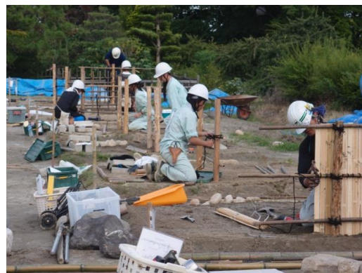
造園工事作業実技試験
